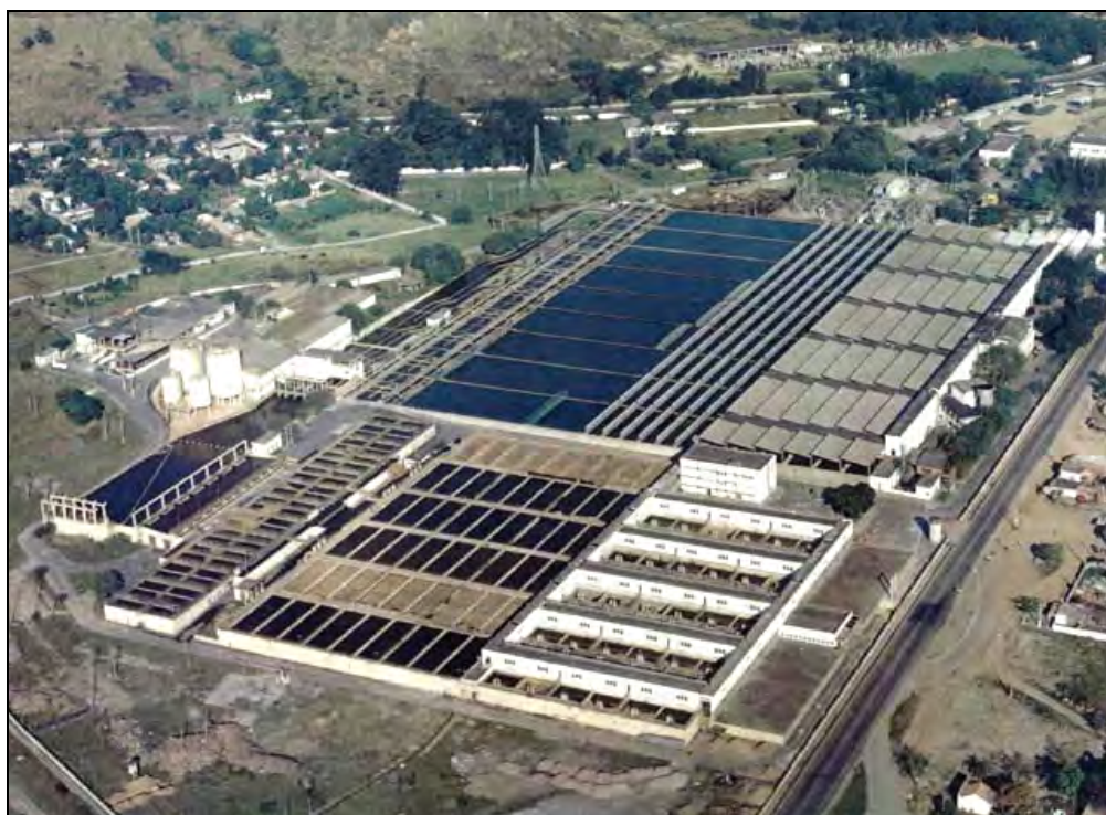
Figura 5. Estação de Tratamento de Água do Guandu, no município de Nova Iguaçu, RJ (Fonte: SERBER, 2005).
