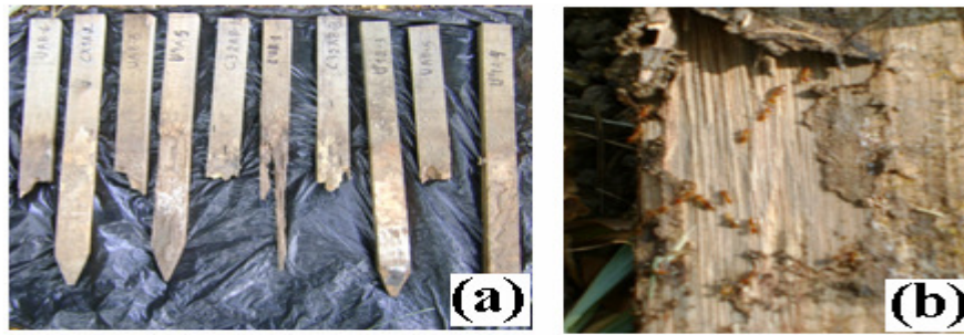
Figura 15 - Campo de Apodrecimento 1 (a) estacas deterioradas; (b) ataque de térmitas do gênero Nasutitermes .
