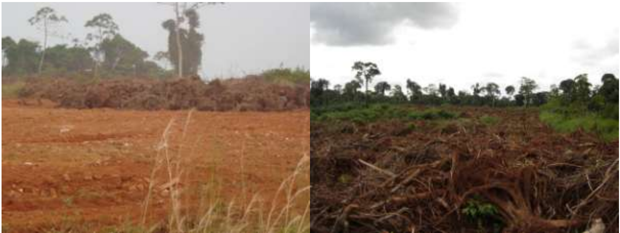
Figura 9. Top soil (solo orgânico) extraído em área de floresta ombrófila, após processo de supressão de vegetação (Fonte: VALE).
