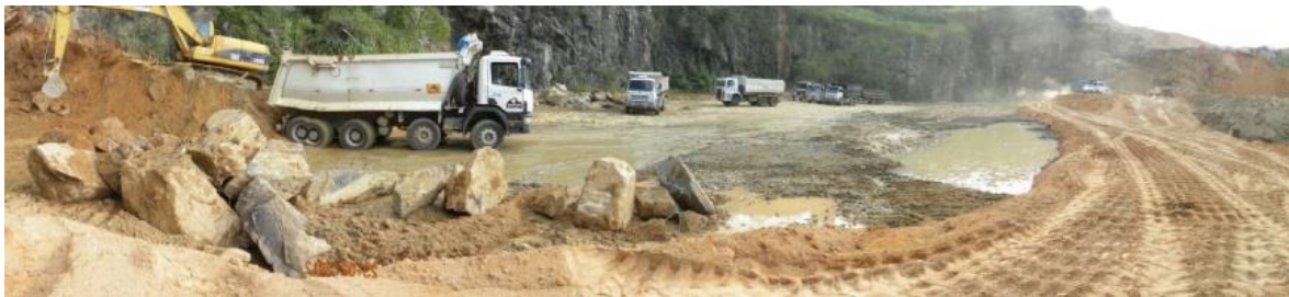
Figura 13 – Construção do Tanque de armazenamento temporário de água, conhecido como o Engenhão.
