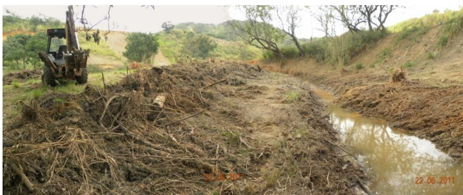
Figura 5 - Verificação da continuidade do escoamento.
