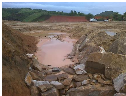
Figura 9 – Tanque de Sedimentação 09, destaque para a construção do vertedouro e início da escada de dissipação de energia.
