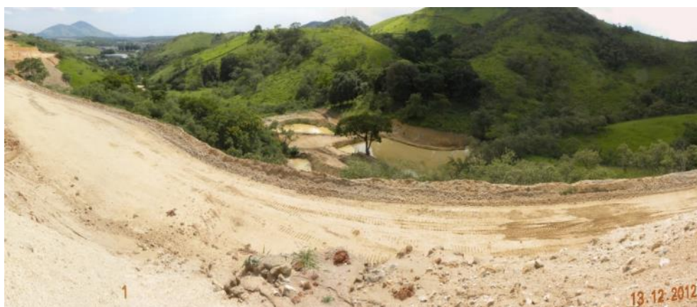
Figura 19 – Conjunto de tanques na extremidade Norte do empreendimento.
