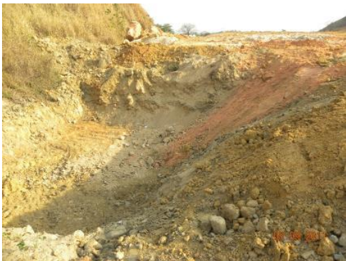
Figura 6 – Abertura do Tanque de Sedimentação do tanque 09, entre o platô industrial e a encosta natural do terreno.
