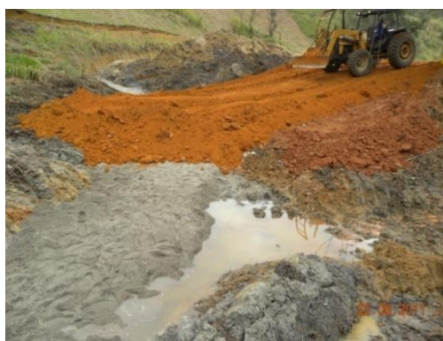
Figura 4 - Forração do talvegue e aterro.
