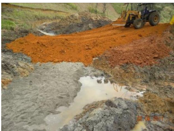
Figura 17 – Tanque de Sedimentação 02, destaque para a construção do aterro – inserção de material externo.
