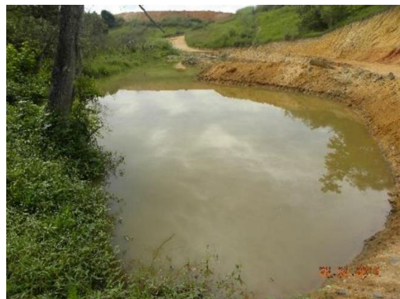
Figura 14 – Início do enchimento do Tanque de armazenamento temporário de água, conhecido como o Engenhão.
