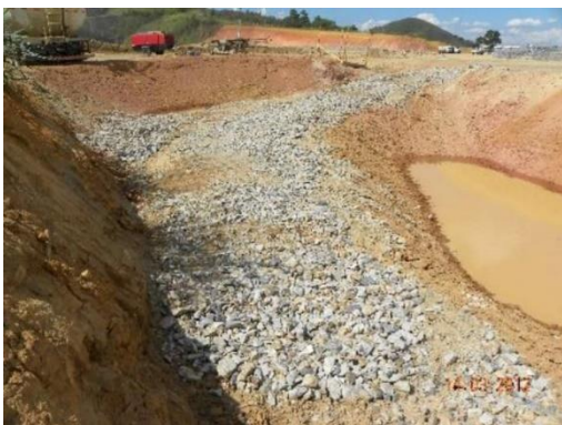
Figura 8 – Tanque de Sedimentação 09, destaque para a construção de acesso do caminhão de limpeza.
