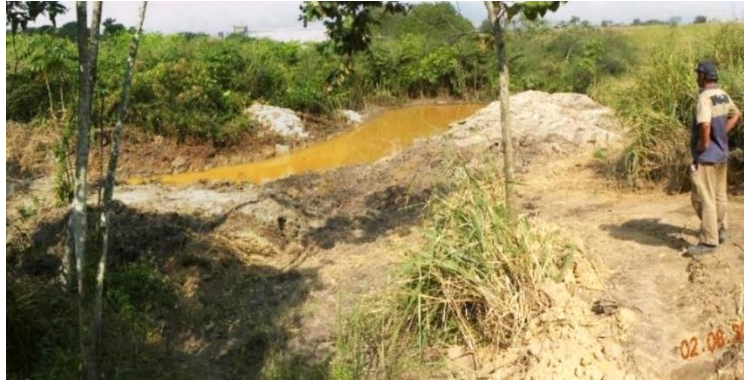
Figura 12 – Identificação e abertura de drenagens.
