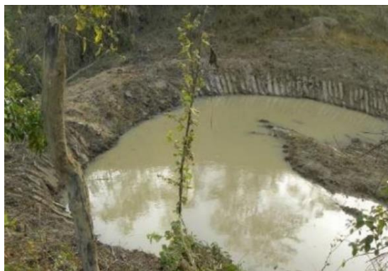
Figura 11 – Tanque de Sedimentação 04, destaque para a construção de acesso do caminhão de limpeza.
