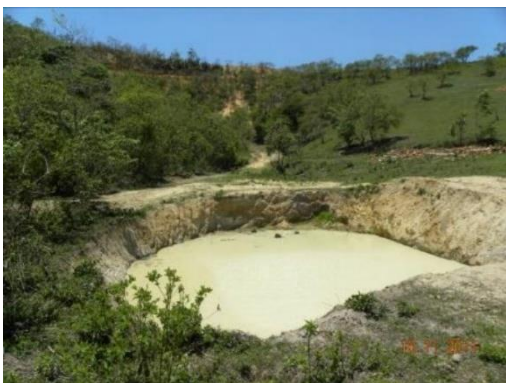
Figura 10 – Tanque de Sedimentação 03 em processo de enchimento.
