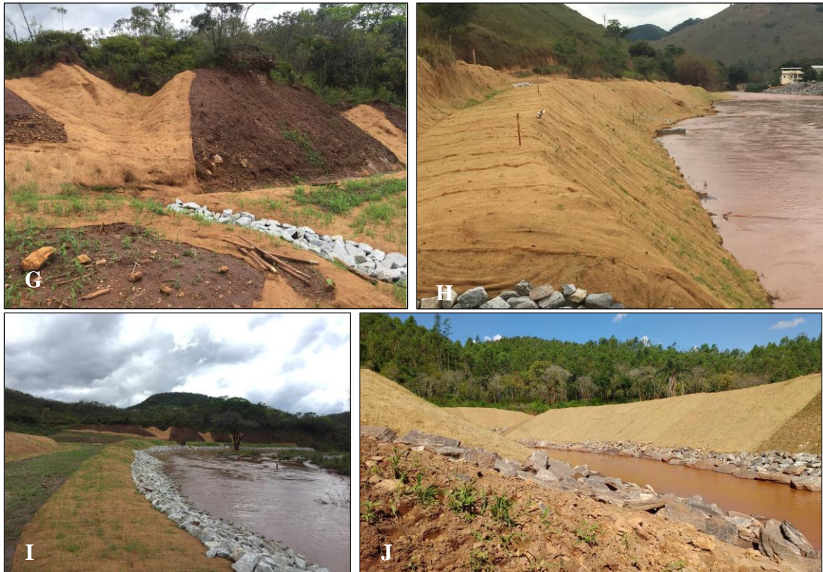
Figura 1. A) Dique em construção. B) Retentores de sedimentos. C) Taludes do rio reconformados com biomanta e retentores. D) Paliçadas e manta geotextêis. E) Muro de gabião. F) Depressão para direcionamento da água de chuva para o rio. G) Canaletas de crista e de berma revestidas com biomanta. H) Proteção com a biomanta. H) Biomanta e enrocamento do rio. I) Intervenções de enrocamento realizadas em um tributário. Fonte: Operação Watu.
