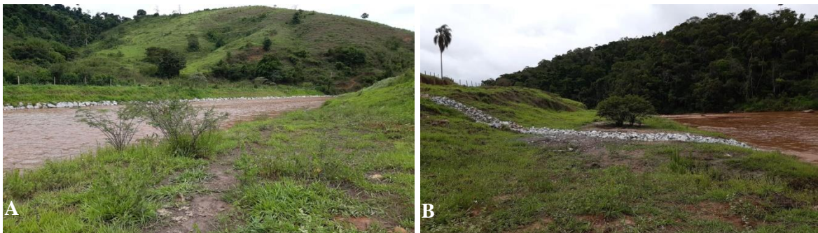
Figura 3. A) Vista de enrocamento do rio. B) Canal de drenagem. Fonte: a autora.
