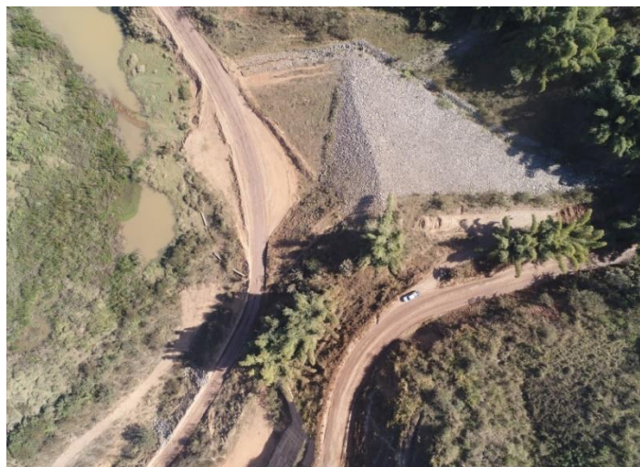
Figura 4. Pedregulhos depositados em trecho do terraço. Fonte: a autora.
