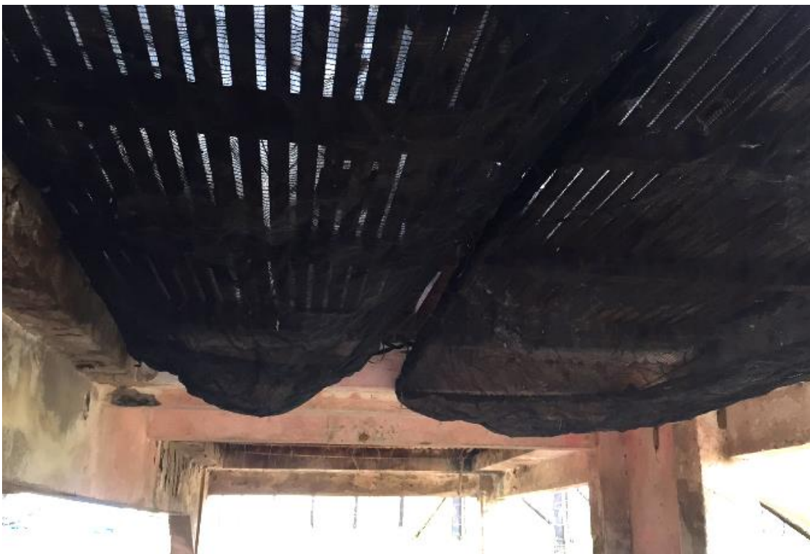
Figura 3 – Coletores instalados abaixo das baias onde permaneceram os animais.
