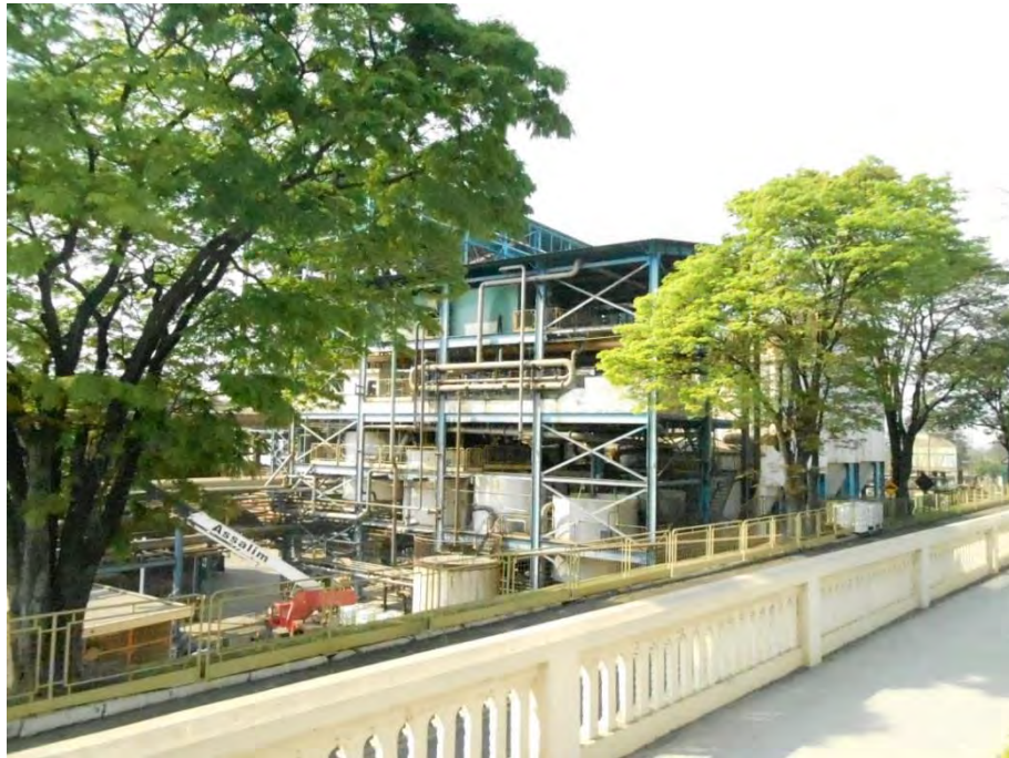
Figura 10: Parte da Usina Costa Pinto
