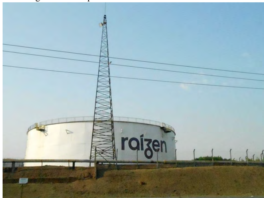
Figura 11: Tanque de armazenamento de etanol
