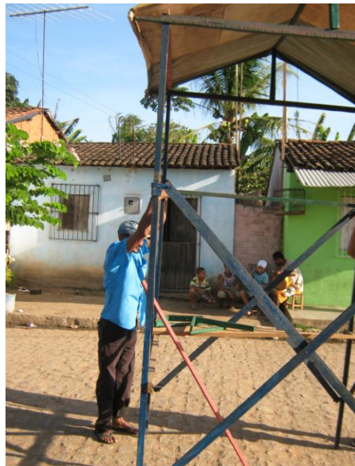
Figura 8: Montagem da empanada de Biu de Dóia, março de 2010.
