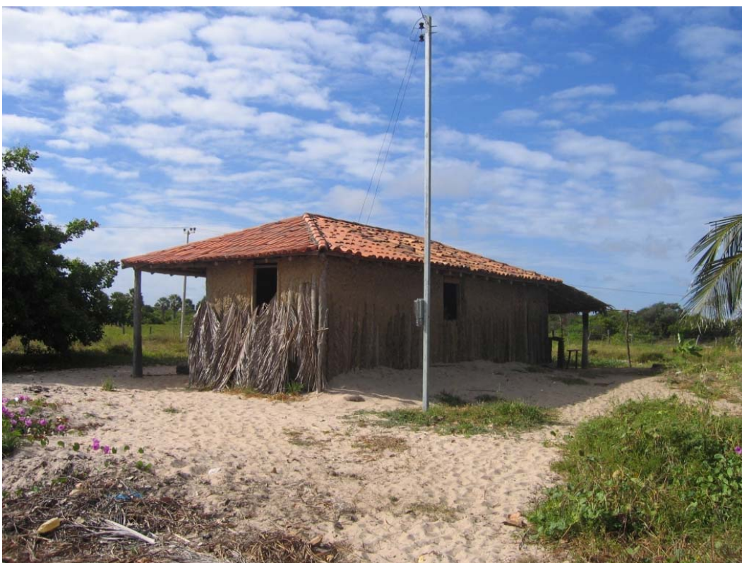
Figura 04: Moradia de taipa e telha de cerâmica – povoado do Passarinho
