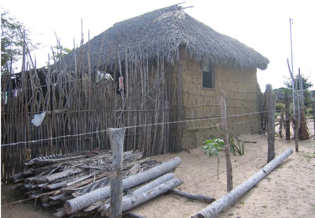
Figura 03 – Moradia de taipa e telhado de palha – povoado do Passarinho.
