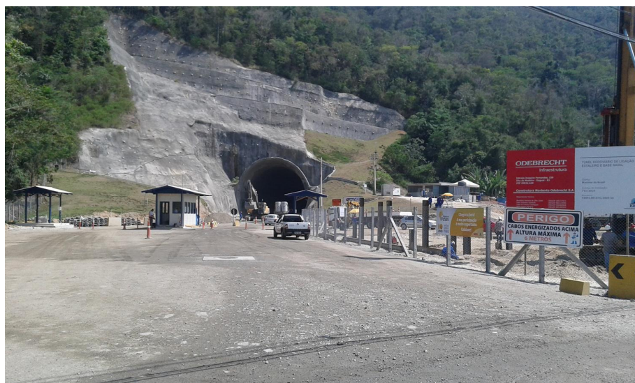
Figura 23: Construção do Túnel Rodoviário de ligação entre Estaleiro e Base Naval.
