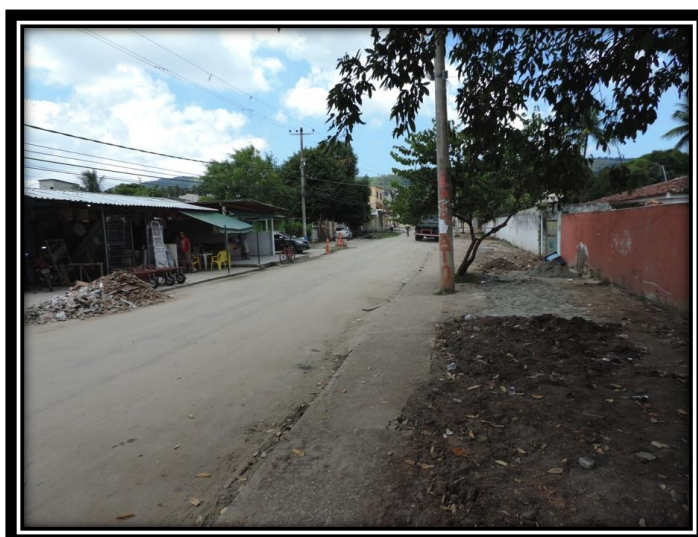
Figura 15 – Obras de infraestrutura no bairro. Fonte: Autor da pesquisa
