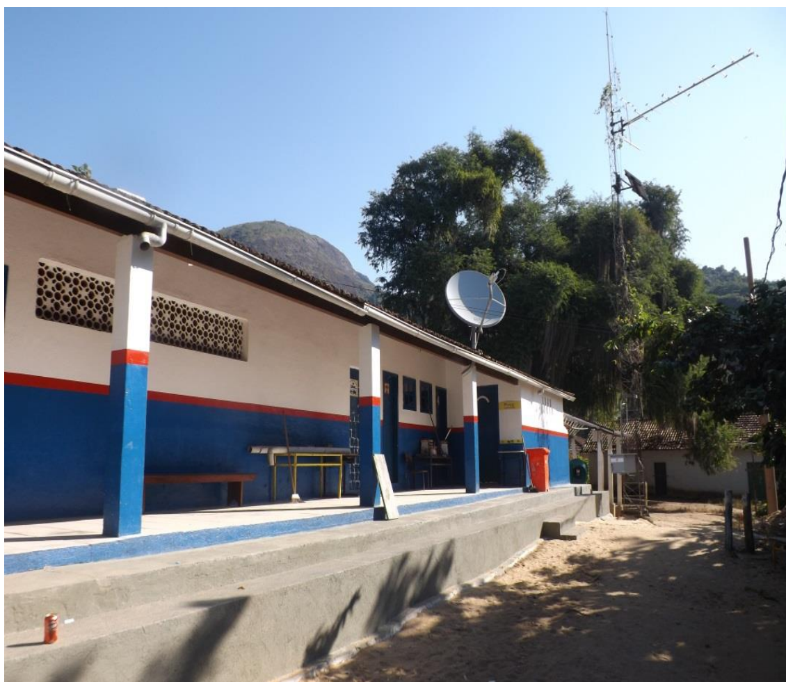
Figura nº 16: Escola Municipal da Cajaíba
