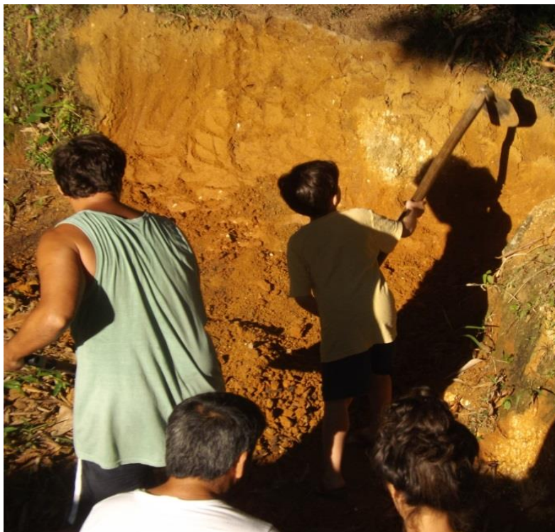
Figura nº 21: Retirada de Barro durante Oficina de Bioconstrução, uma das Oficinas promovida pelo Instituto de Permacultura Caiçara (IPECA) no Pouso da Cajaíba.
