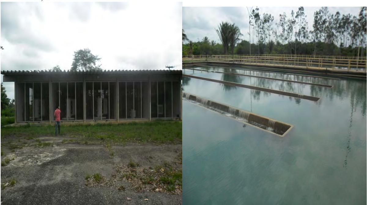
**Figura 24** – Imagem da casa de força responsável em suprir a enorme demanda de energia elétrica para movimentação dos equipamentos elétricos da ETA-Italuís e dos últimos tanques de separação onde já supostamente se encontra água indicada para uso, sendo necessária esta confirmação em teste de laboratório para liberação da água para o duto de distribuição que percorre 56 km até São Luis, Maranhão, Brasil.
