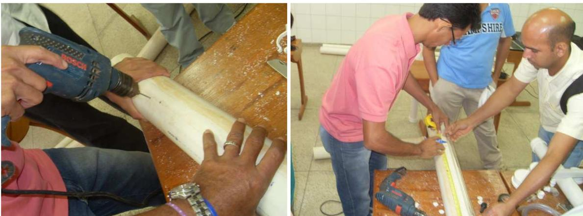
**Figura V** – Marcação e cortes realizados com broca de 8,0 mm para fixação de materiais ao tubo de 100 mm de diâmetro.
