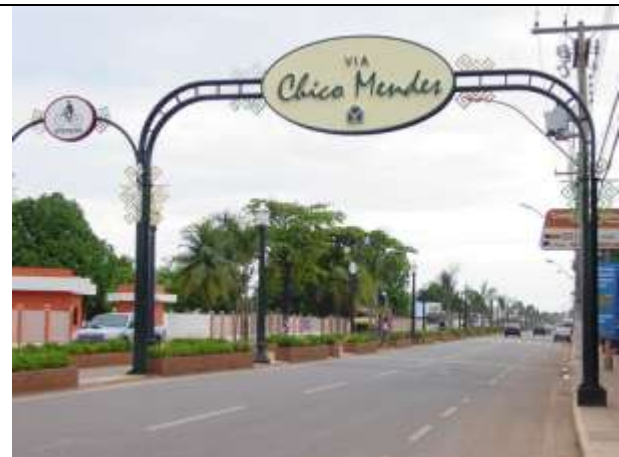
Rodovia AC 40, em trecho urbano, reformada em 2003 e rebatizada de "Via Chico Mendes" em Rio Branco/AC.
