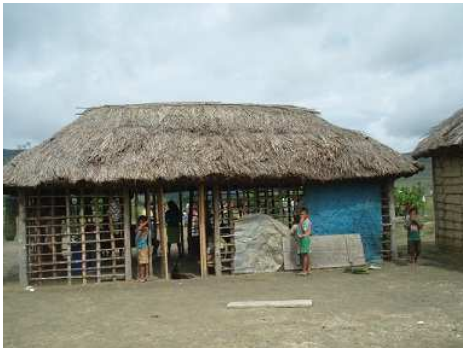
FIGURA 27 – ETAPAS DA CONSTRUÇÃO DE UMA CASA.
