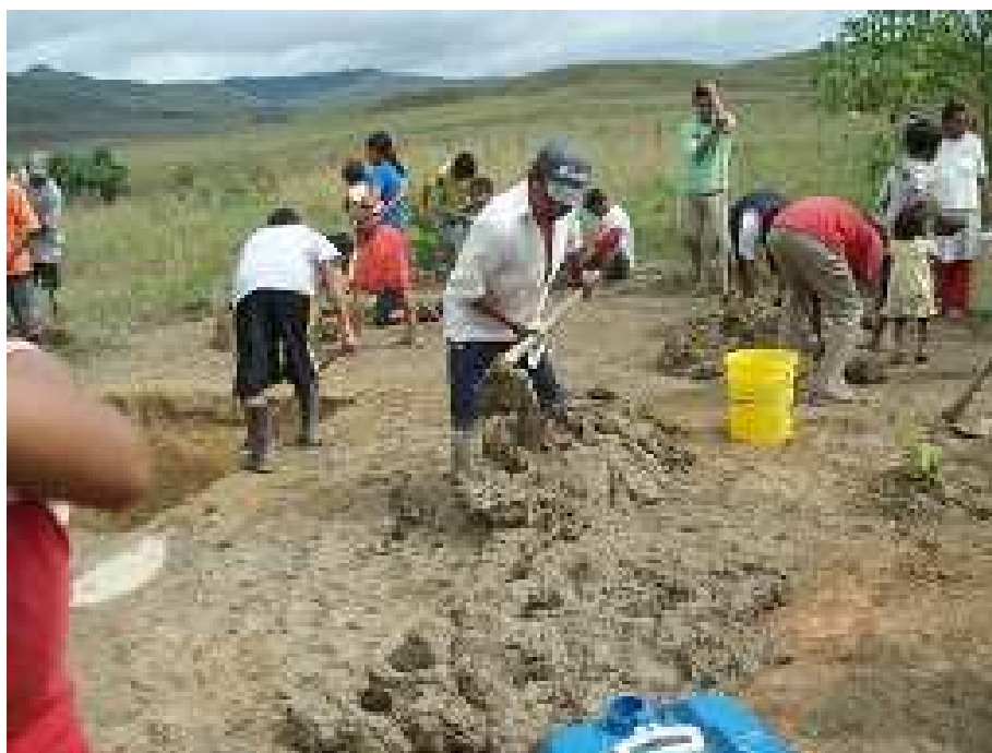
FIGURA 28 – ETAPAS DA CONSTRUÇÃO DE UMA CASA.
