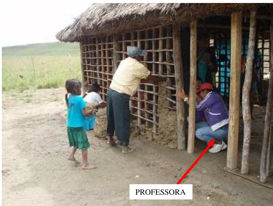
FIGURA 30 – ETAPAS DA CONSTRUÇÃO DE UMA CASA.
