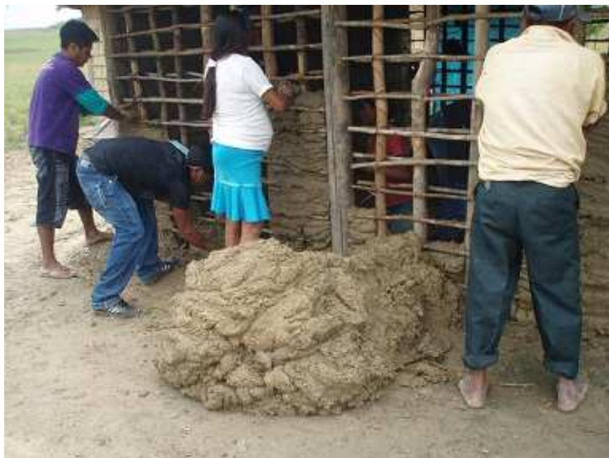
FIGURA 29 – ETAPAS DA CONSTRUÇÃO DE UMA CASA.
