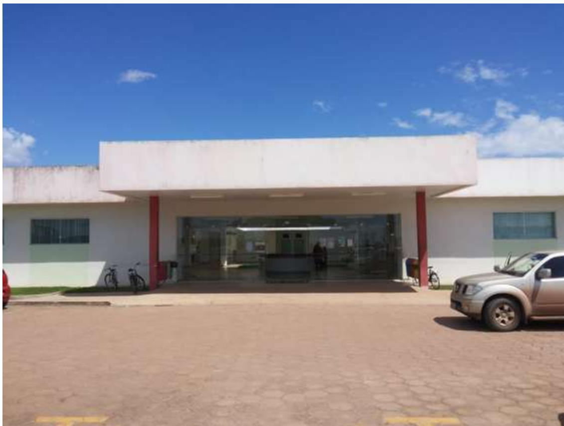
Figura 3 - Entrada Principal do IFAP.
