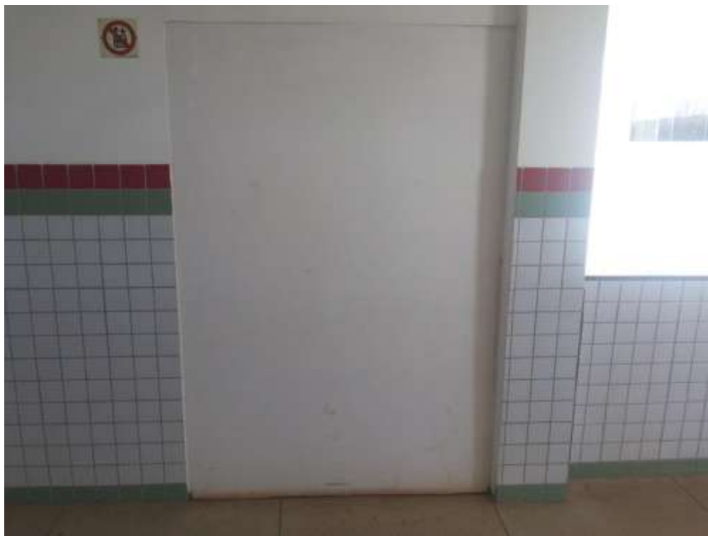
Figura 5 - Poço para implantação de plataforma de acessibilidade. Fonte: André Côrtes, 2014.
