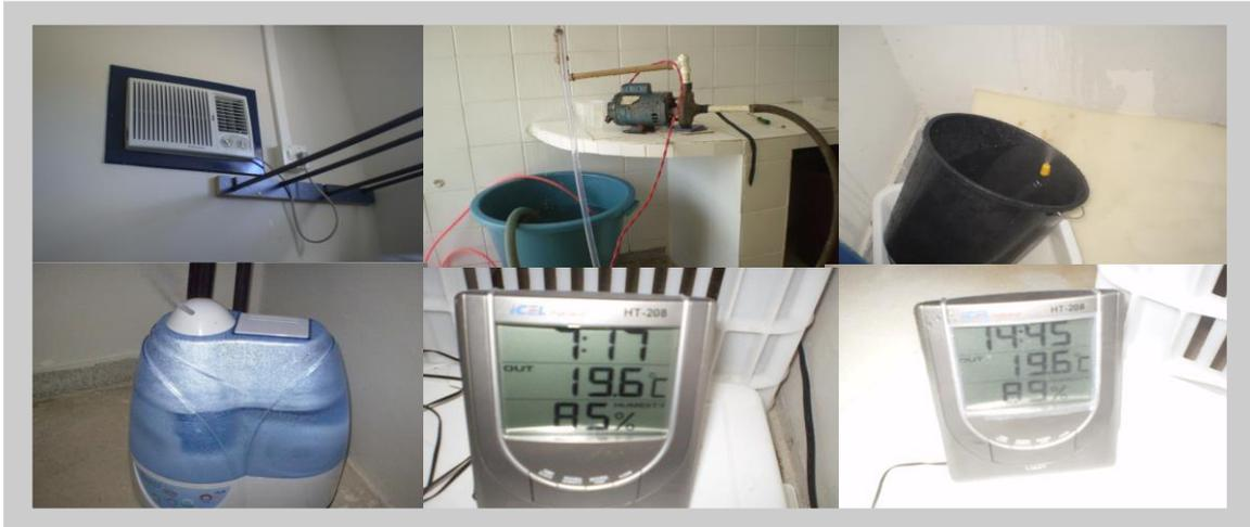
Figura 6- Elementos utilizados para adequar a temperatura do local de fermentação e maturação. Fotos tiradas pelo funcionário do IFPB, Campus Sousa: Dorgival de Assis
