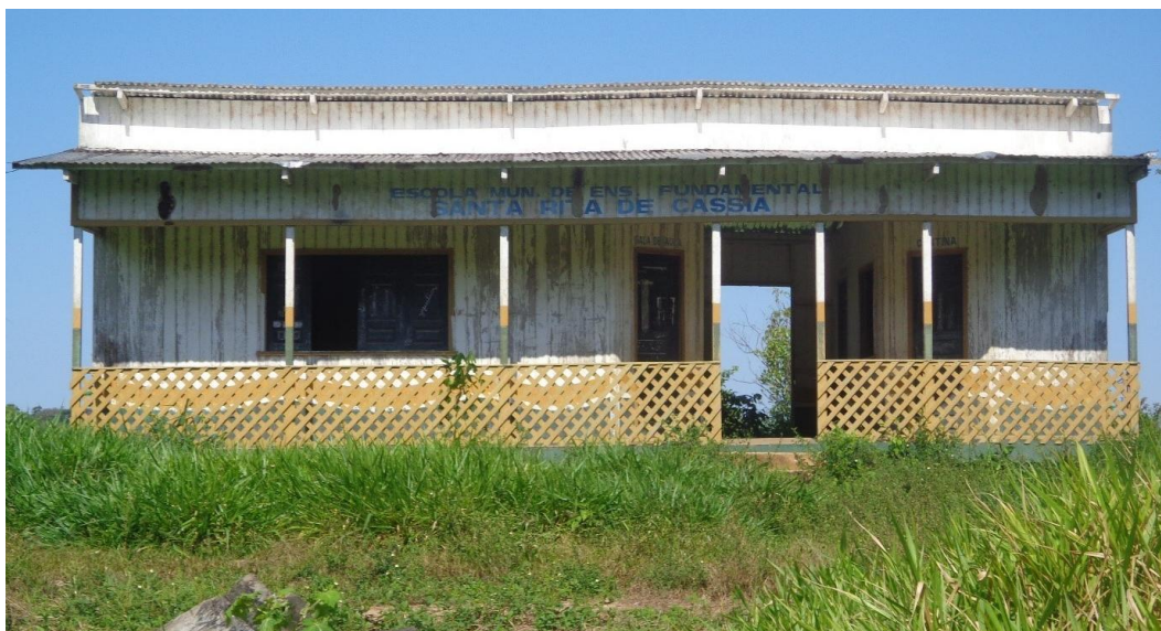
Figura 4 - Prédio da Escola Santa Rita de Cássia.
