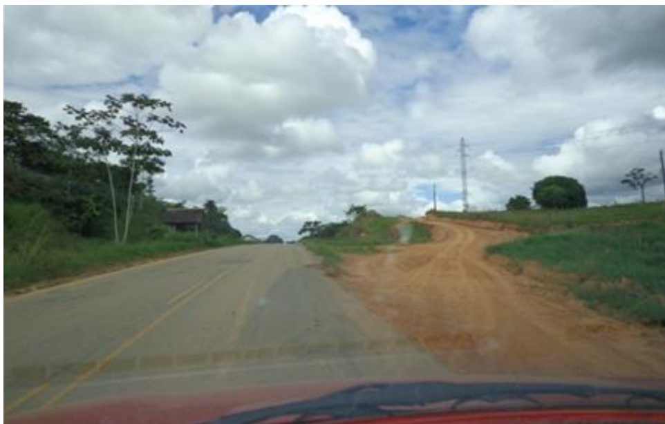
Figura 14 - Entrada do ramal de acesso à escola.
