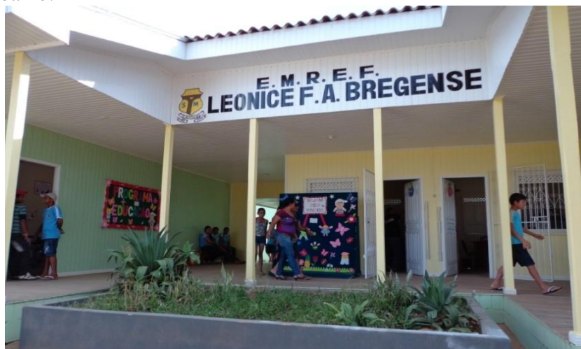
Figura 12 - Fachada da Escola Municipal Rural Leonice F. de A. Bregense.
