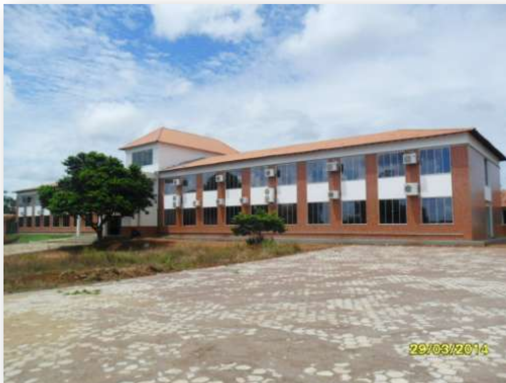
Figura 04: Foto do Prédio Principal, em 29/03/2014.
