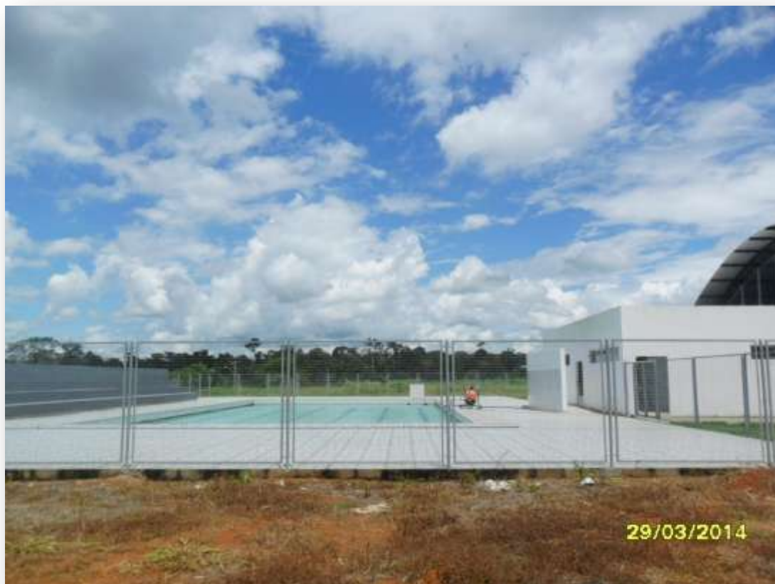
Figura 07: Foto da Piscina, em 29/03/2014.
