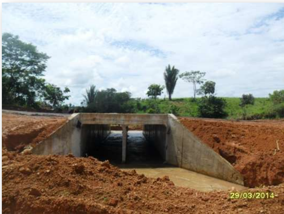
Figura 10: Visão Parcial da Galeria Recém Construída, em 29/03/2014.
