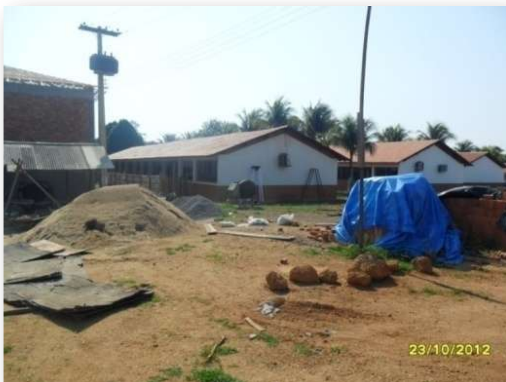
Figura 03: Foto dos Blocos de Salas de Aula, em 23/10/2013.
