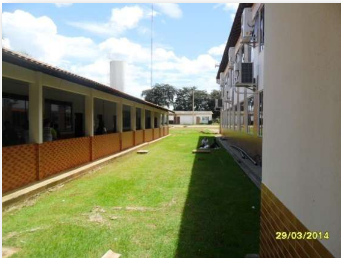
Figura 06: Visão Parcial de Bloco de Sala de Aula, em 29/03/2014.
