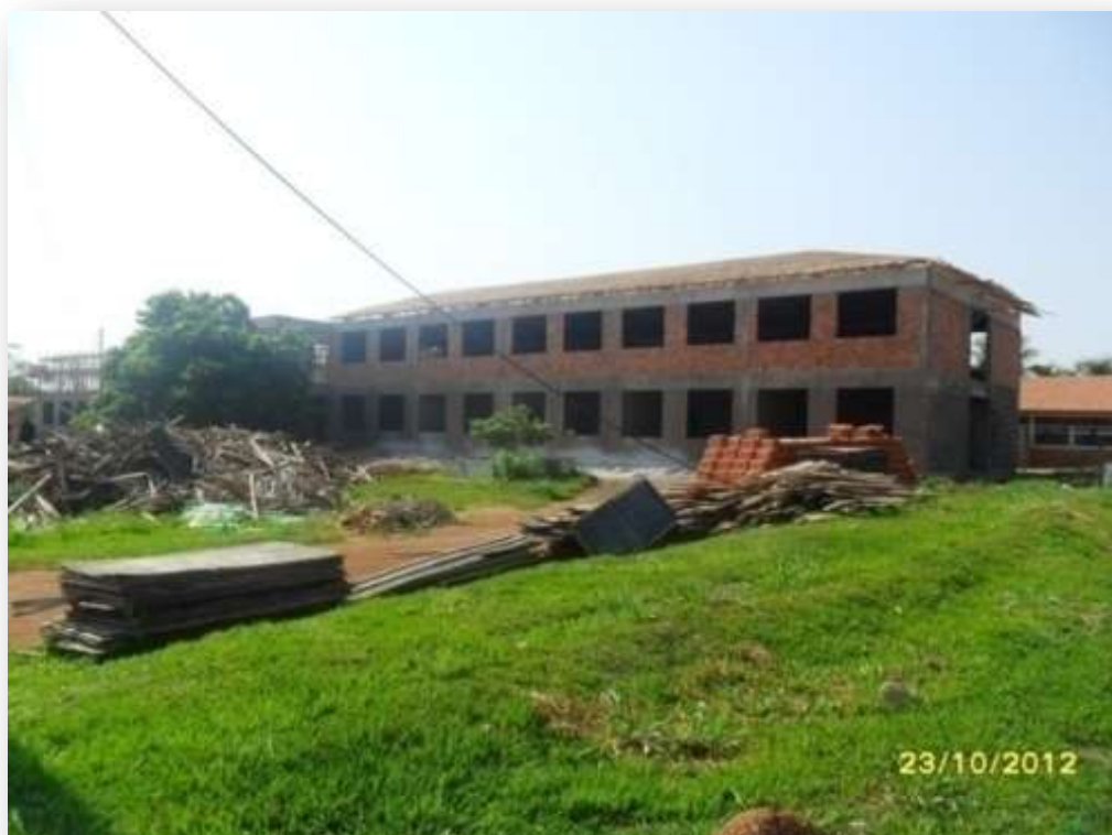
Figura 02: Foto do Prédio Principal, em 23/10/2012.
