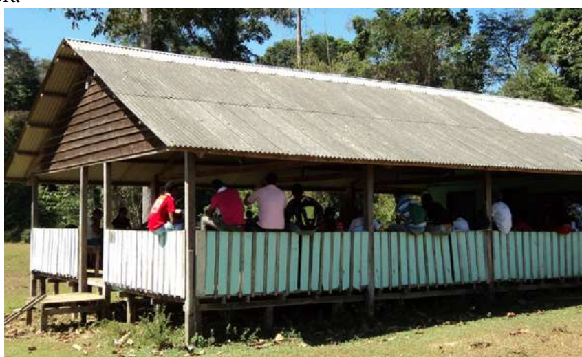
Figura 14: Aula teórica - sala de aula Fonte: A autora
