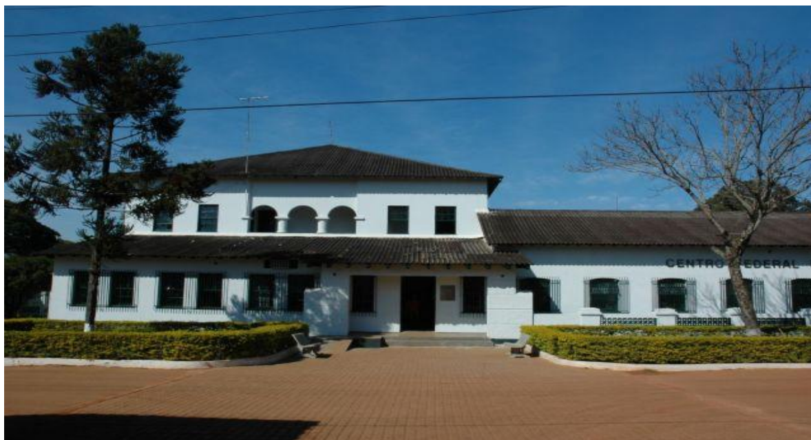
Figura 2 – Vista frontal da Sede Administrativa do IFMT – Campus São Vicente
