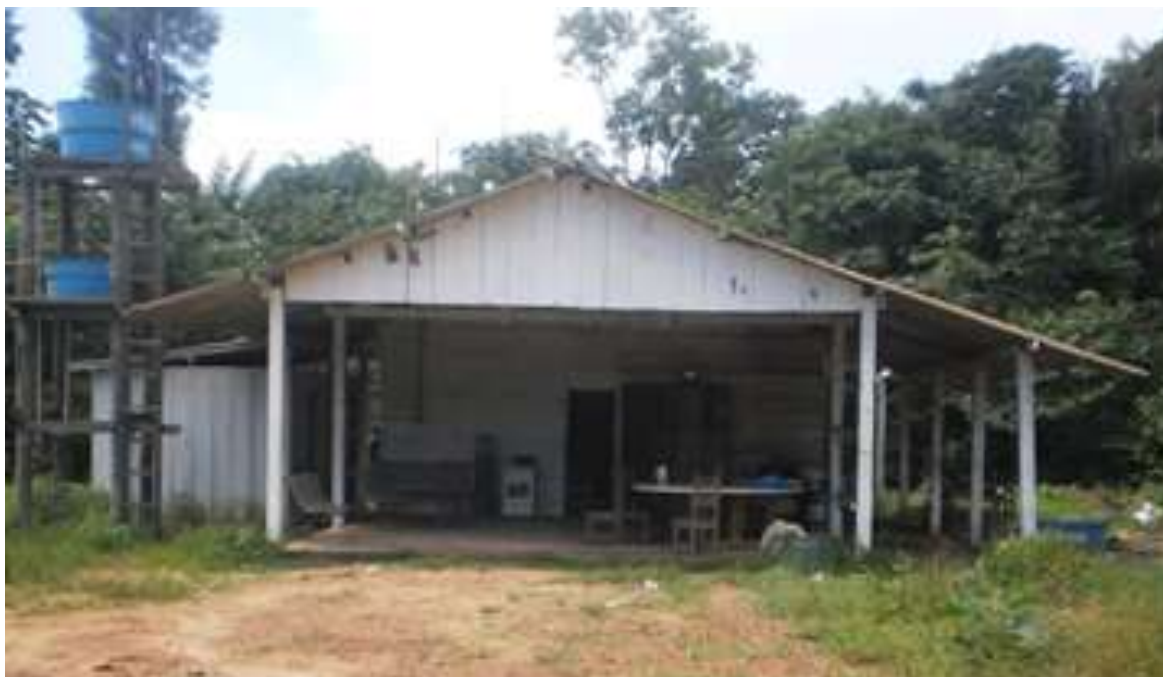
Figura 44. Galpão de apoio aos pescadores no projeto Ipirá
