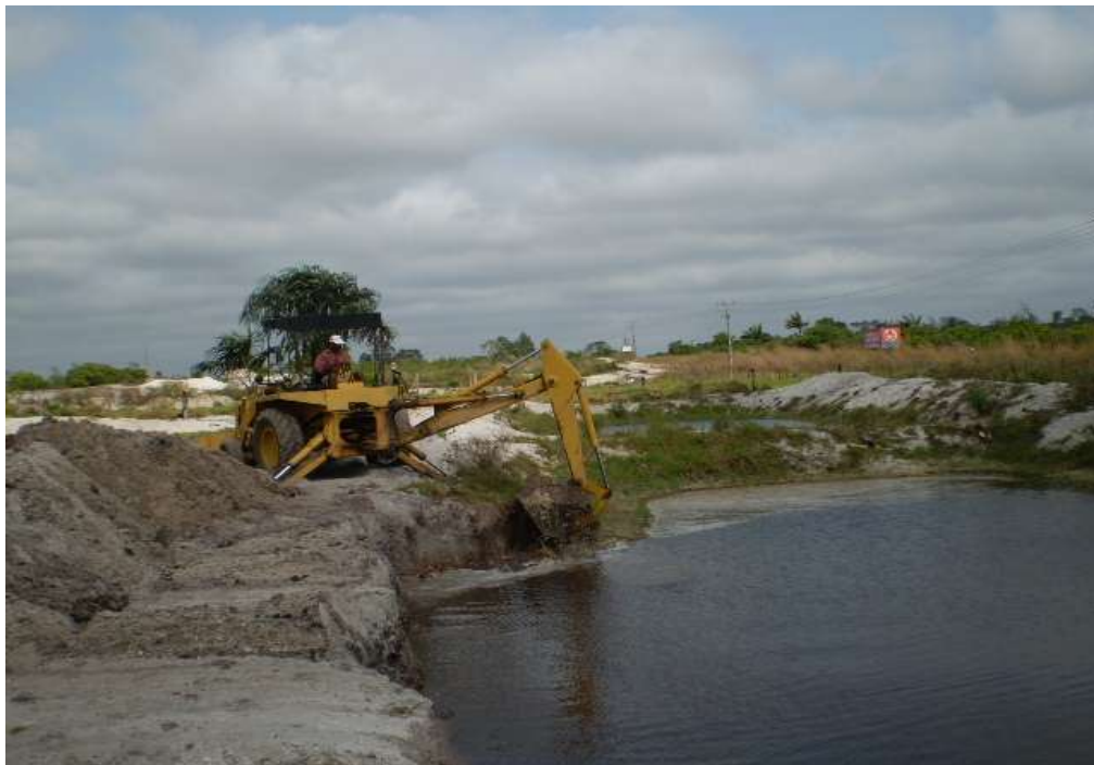
Figura 32. Ampliação dos tanques escavados
