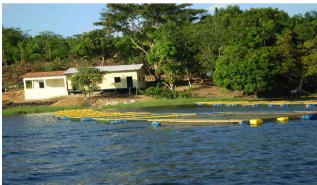
Figura 36. Casa de apoio e Barracão de armazenamento de ração. Fonte. Vaz, 2016
