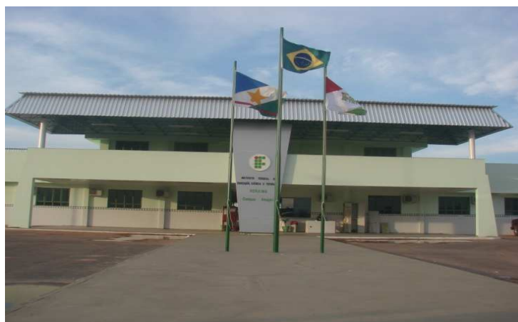
Foto I: Entrada do Prédio Administrativo do Campus Amajari
