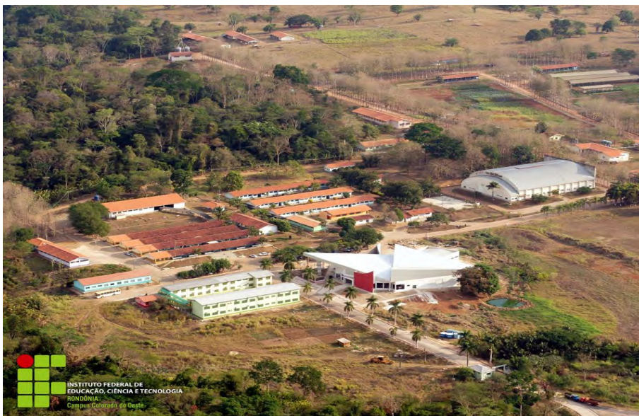
Figura 10: Vista aérea de parte da área do IFRO – Câmpus Colorado do Oeste. Fonte: Acervo do IFRO – Câmpus Colorado do Oeste (2012).
