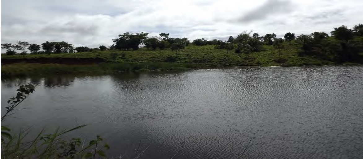
Figura 34: Ausência de mata ciliar e desbarrancamento do talude. Fonte: Fonte própria (2012).
