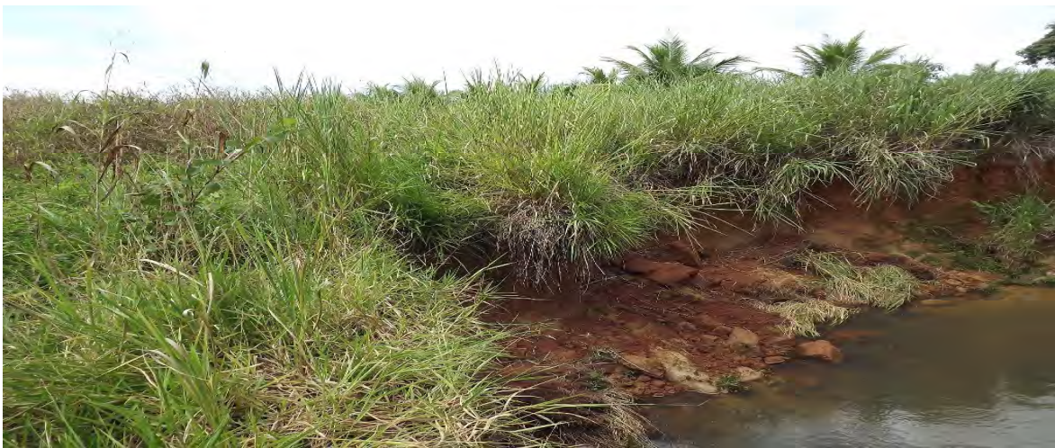
Figura 39: Desbarrancamento no talude do rio devido à ausência de mata ciliar e presença de pastagem até a borda do rio no setor de Agricultura. Fonte: Fonte própria (2012).
