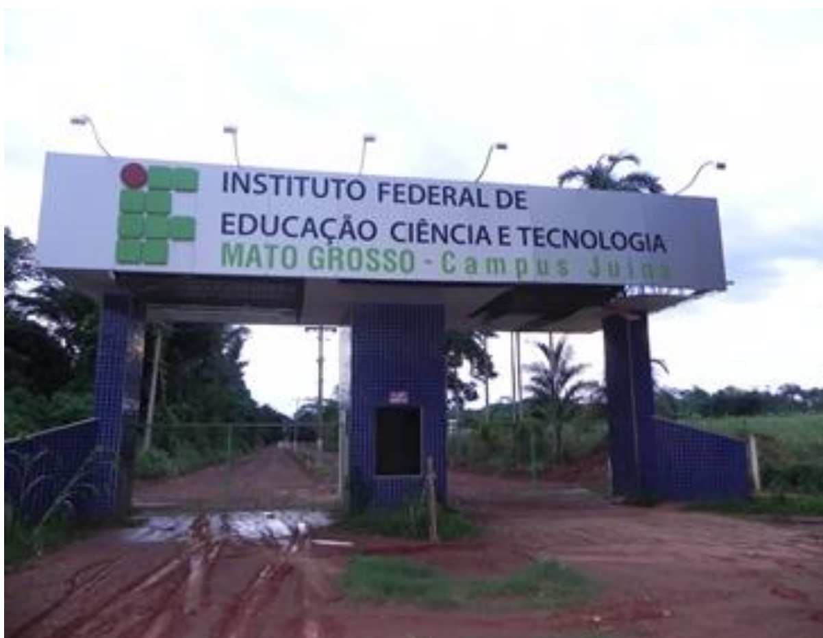
Figura 09 - Fachada de entrada do IFMT Campus Juína. Imagem, 2012.
