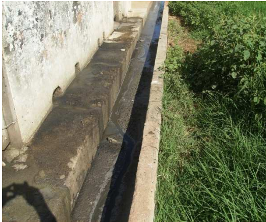
Figura 10 – Caneleta de captação de dejetos dos suínos
