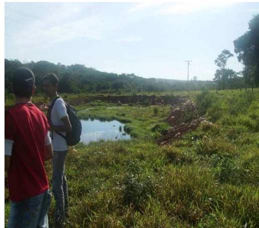
Figura 13 – Visita à lagoa de tratamento dos dejetos dos suínos – Lagoa facultativa
