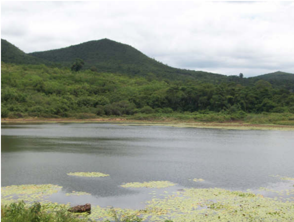
Figura 8. Barragem construída pela Leste Ferrovias dentro do assentamento
