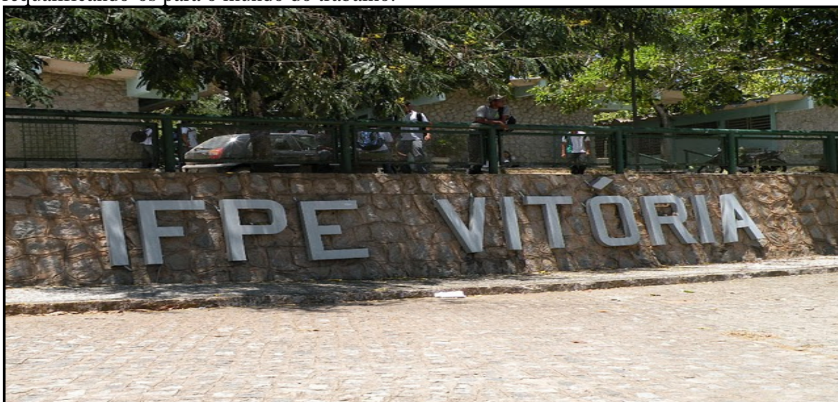
Figura 04: Fachada do Prédio Principal do Campus Vitória de Santo Antão
