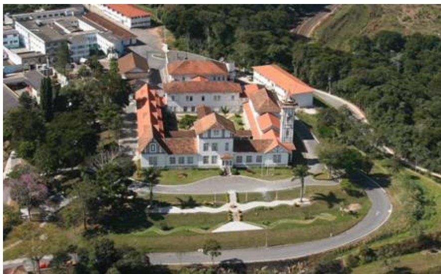
Figura 4 - Vista aérea do Instituto Federal de Educação Ciência e Tecnologia do Sudeste de Minas Gerais - Campus Barbacena 7 .
