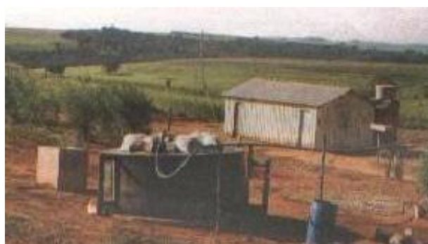
Figura 15: Residências abastecidas com biogás Fonte: Jornal da Unesp – Junho 2006
