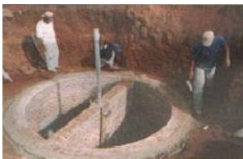
Figura 14: Fase de construção do biodigestor Fonte: Jornal da Unesp – Junho 2006
