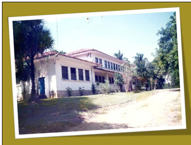
Figura 6: Instalações da antiga ladeira da meteorologia
