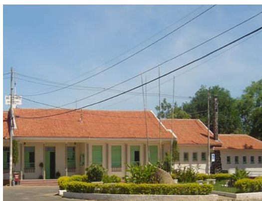
Figura 1 - Vista parcial do prédio pedagógico da EAFSalinas – MG
