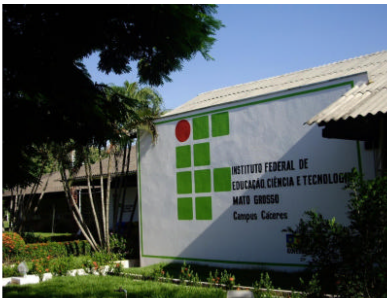
Figura 2 – Parte Frontal do IFMT/Campus Cáceres
