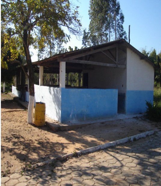
Figura 6. - Instalação de matrizes em gestação
