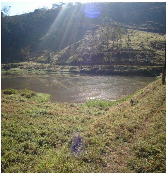
Figura 13. – Açude existente à montante.
