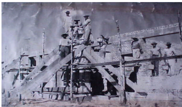
Figura 01 - Escola de Iniciação Agrícola em construção.
