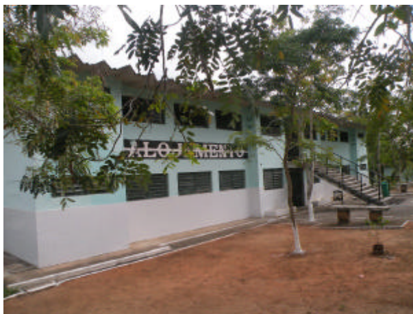
Figura 7: Prédio do internato masculino
