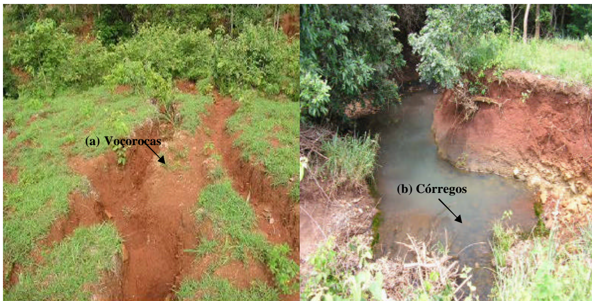
Figura 6: Voçoroca (a) em área de pastagem contribui para o assoreamento do córrego (b) do assentamento. Com a substituição do Cerrado original por atividades de agropecuária, instauram-se na área processos de degradação ambiental. Assentamento Poções, 2007.
