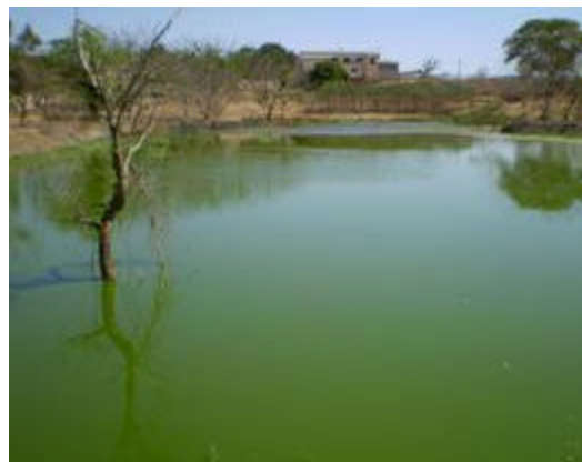
FIGURA 23: lagoa de armazenamento de dejetos sem revestimento, causando contaminação do solo e lençol freático.
