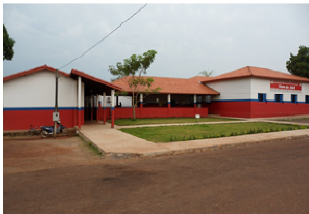
Figura 13 – Fachada da Escola Vinte de abril em 2013
