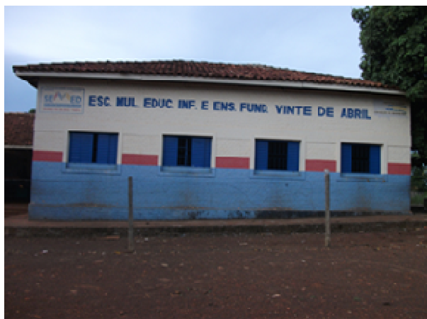
Figura 12 – Fachada da Escola Vinte de abril em 2011
