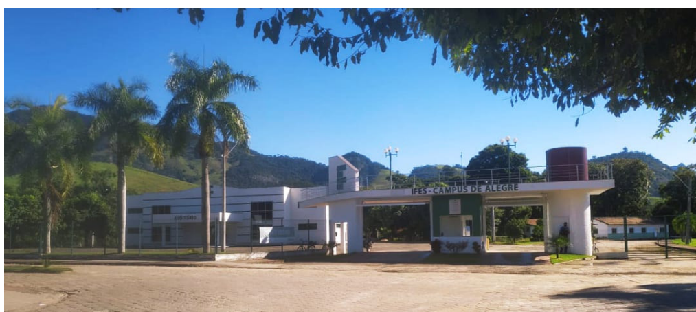
Figura 2 – Acesso principal ao IFES Campus de Alegre
