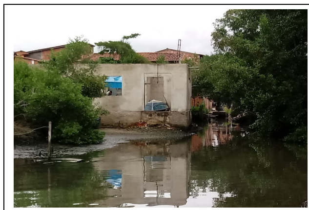
Figura 9: Imagem de uma das casas construída dentro do mangue. Fonte: Autora, 2020.
