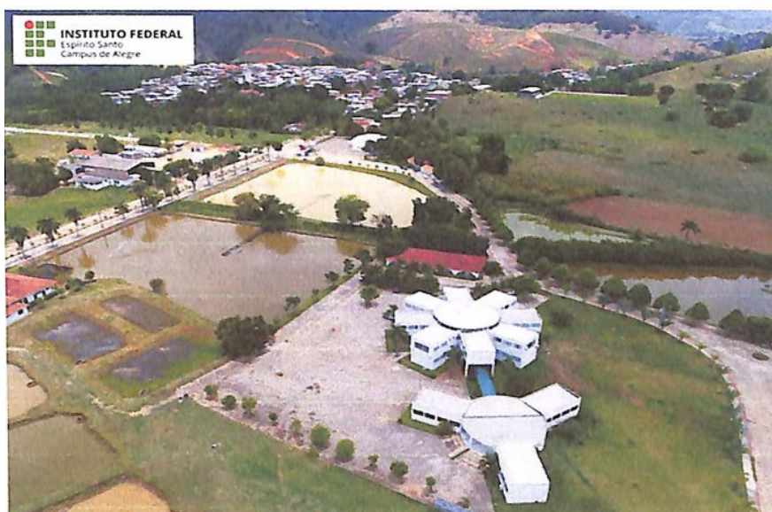
Figura 6 - Imagem aérea do prédio do ensino superior. Fonte: Acervo Ifes - campus de Alegre
