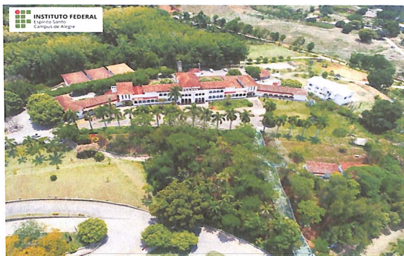
Figura 4 - Imagem aérea do prédio principal do Ifes - campus de Alegre. Fonte: Acervo Ifes - campus de Alegre
