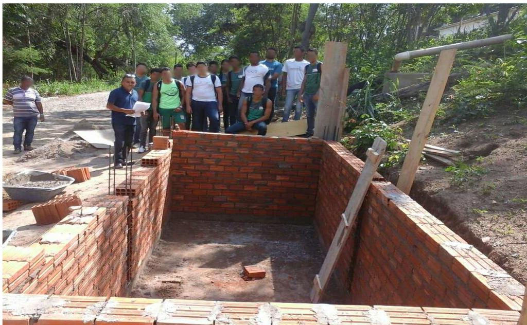
**Figura 2.** Estudantes da disciplina de Construção e Instalação Rural durante a construção do TEvap no IFCE *campus* Crato.
