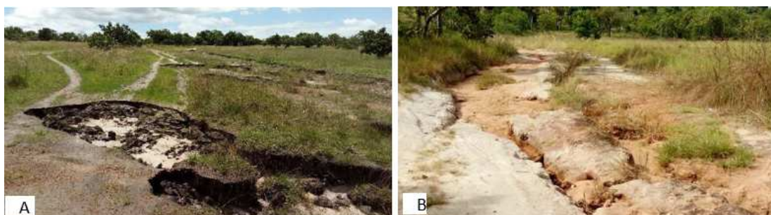
Figura 13 - (A) Processos erosivos tipo voçoroca na CITC; (B) Processos erosivos tipo sulcos e ravinamentos na CITC
