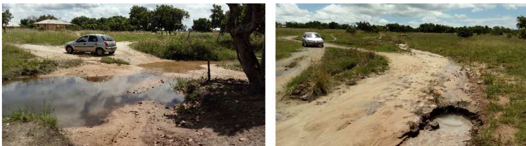
Figura 8 - Fluxo de automóveis: causa de erosão e assoreamento dos igarapés na CITC
