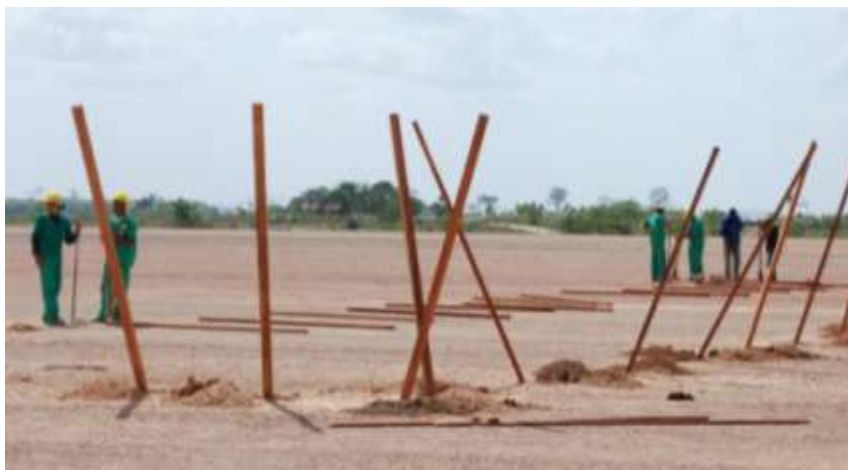
Figura 4 – Início das obras da sede própria do CAM Fonte: ASCOM/IFRR
