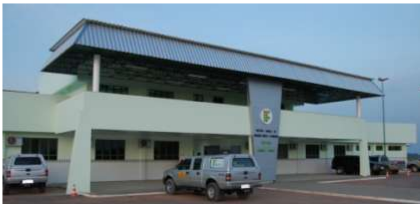
Figura 5 – Fachada principal do prédio do CAM
