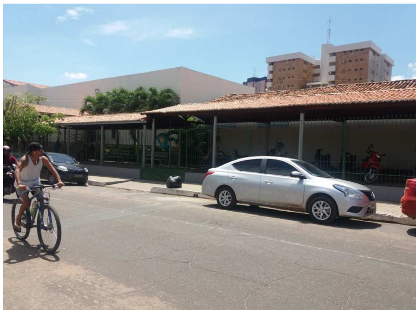
Figura 1. Escola Estadual de Ensino Fundamental e Médio Teodorico Teles Quental. Fonte: autor.
