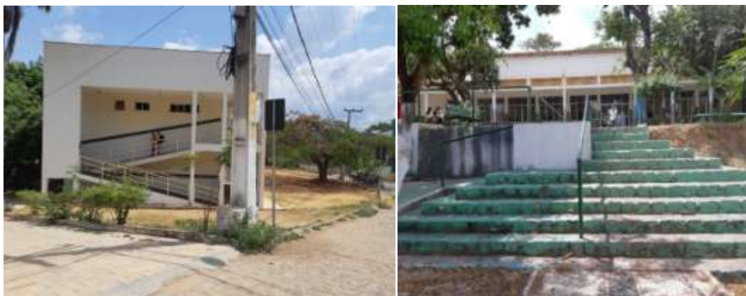
Figura 2 - Bloco 1 (sala de aula e refeitório)
