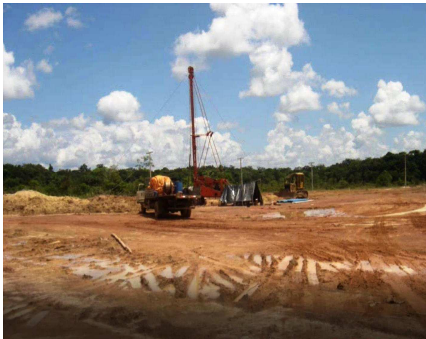
Figura 10 – Canteiro de obra da Uned de Novo Paraíso
