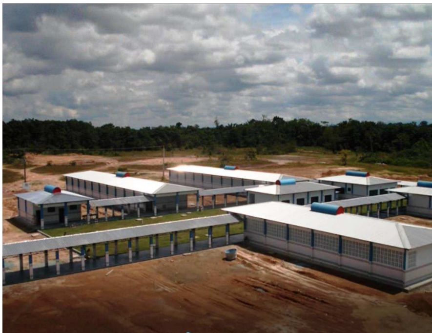
Figura 11 – Primeira fase da obra da Uned de Novo Paraíso concluída
