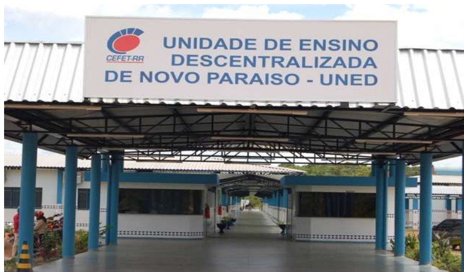
Figura 20 – Unidade de Ensino Descentralizada de Novo Paraíso Fonte: Acervo do IFRR, 2018
