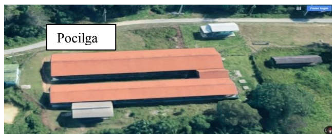
Figura 4 – Vista do telhado da pocilga
