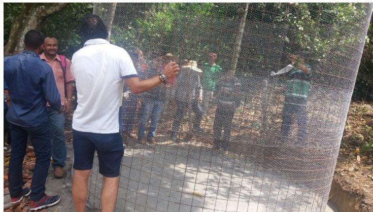
Figura 28 – Armação do Cilindro com a tela
