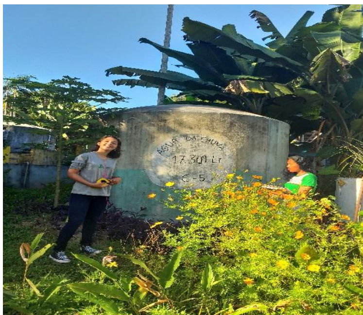
Figura 13 - Medição do perímetro e da altura da cisterna 5 Fonte: Próprio autor
