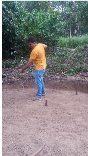
Figura 21 – Nivelamento do terreno com a curva de nível e traçado do raio da base Fonte: Próprio autor
