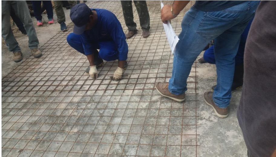
Figura 27 – Tela de Galinheiro sendo presa na tela de ferro
