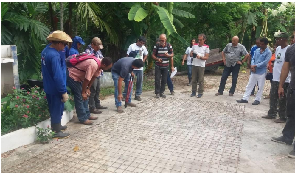
Figura 25 – Malha de ferro estendida para ser colocada na parte lateral da Cisterna Fonte: Próprio autor
