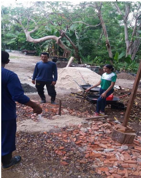
Figura 23 - Compactação da base da cisterna
