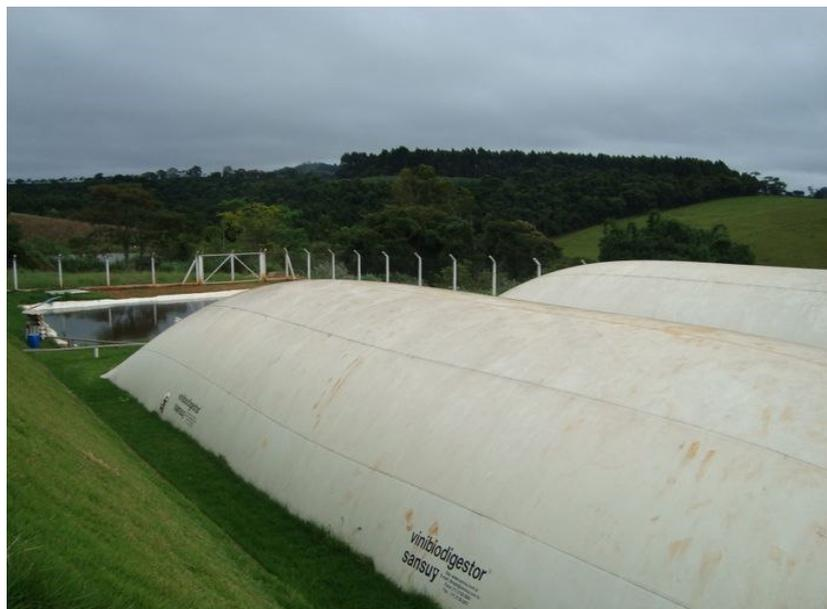
**Figura 4:** Biodigestor Modelo Canadense
