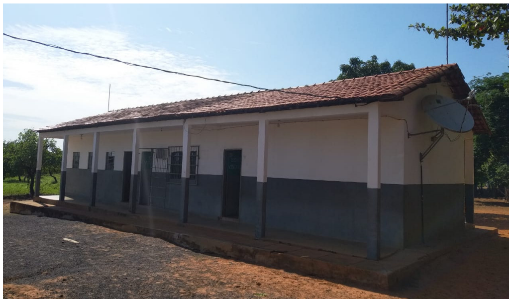
Figura 6 - Fachada da Escola Municipal Povoado Rodovilândia
