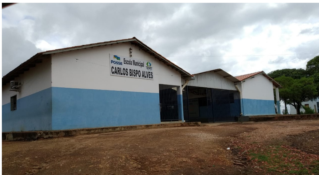
Figura 4- Fachada da Escola Municipal Carlos Bispo Alves
